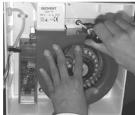
Ventilatoreinsatz je nach Einbaulage in das Gehäuse schieben
